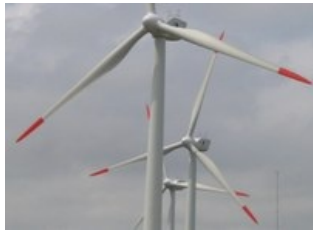
Aerogeneradors de Milà
