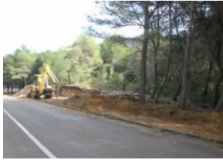
Obres a Son Parc
